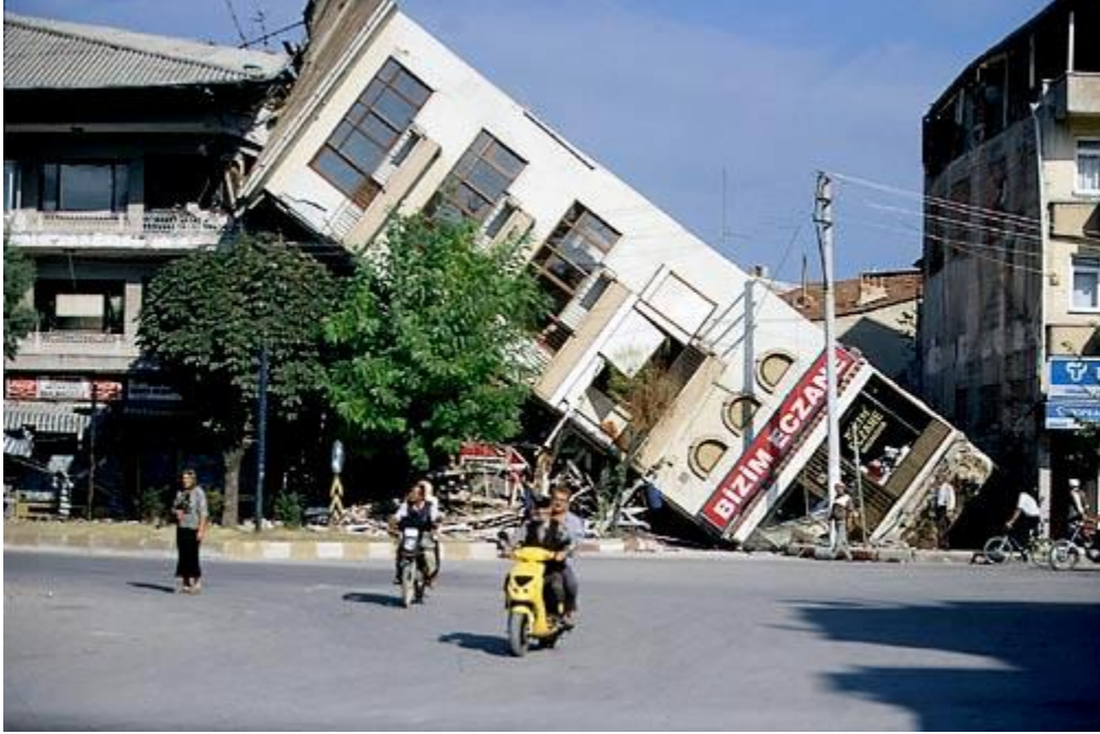
Van Depremi: Yandaki bina da depremde hasar verebilir (kaynak: www.kovancilardh.gov.tr )
