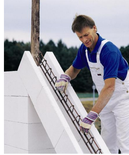
Resim 3: Kalkan duvar üzerine kagir birim kalıp içine donatılı hatıl uygulaması.
